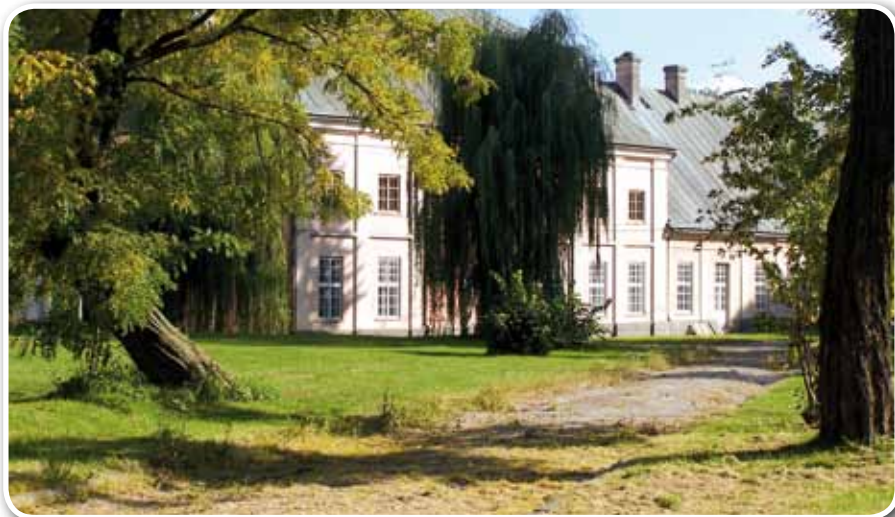
Pałac Lubomirskich w Boguchwale
