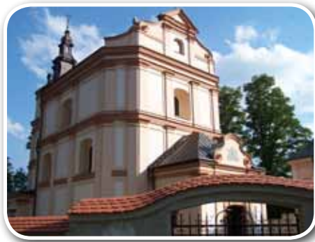
Zabytkowy kościół w Boguchwale z XVIII w. po renowacji
